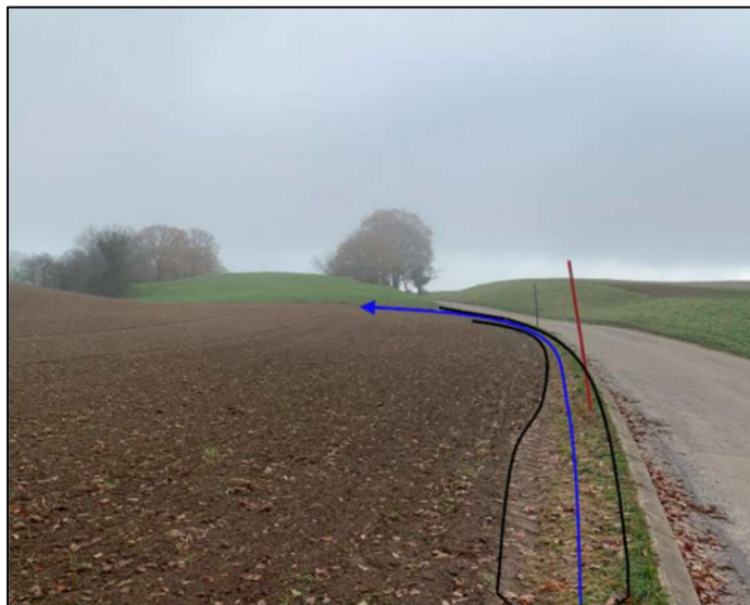
Figure 5 Groupe A – fossé drainant en place pour évacuation côté champs
