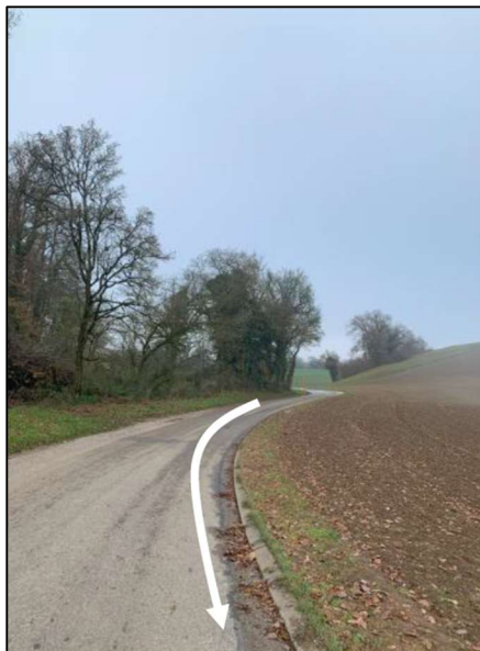
Figure 4 Groupe A – évacuation naturelle sur chaussée
