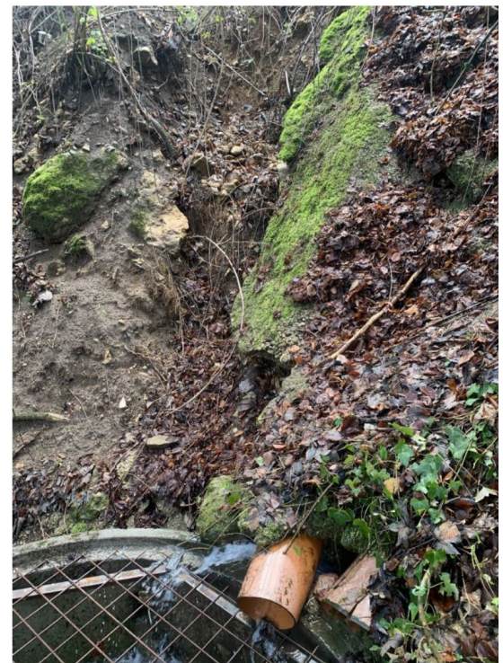
Figure 5 gauche et droite : Dégâts au niveau des deux tuyaux PVC arrivant dans la chambre circulaire
