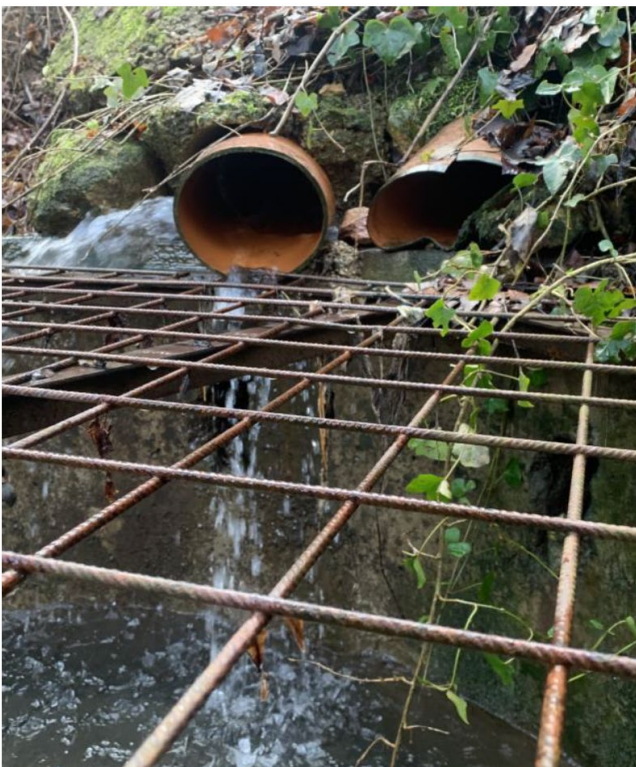
Figure 5 gauche et droite : Dégâts au niveau des deux tuyaux PVC arrivant dans la chambre circulaire
