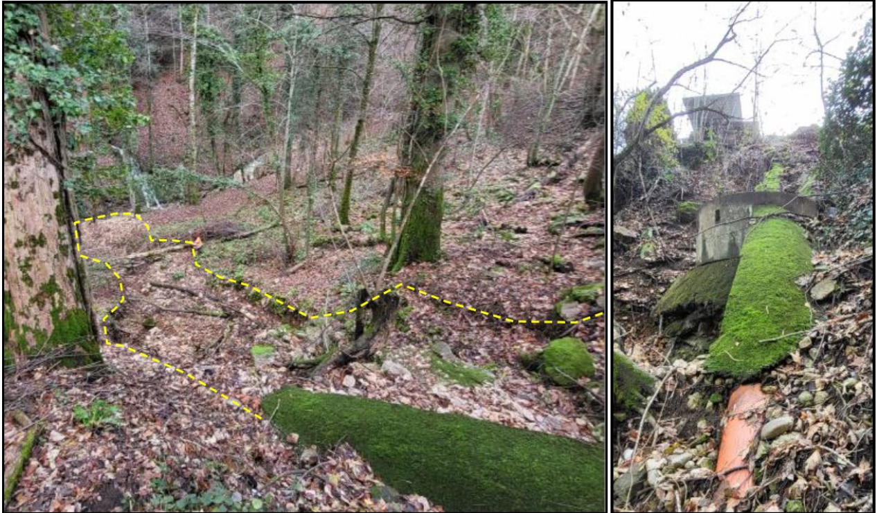
Figure 2 gauche : Emprise du ravinement (hachuré jaune) / Droite : Chambre en haut du talus
