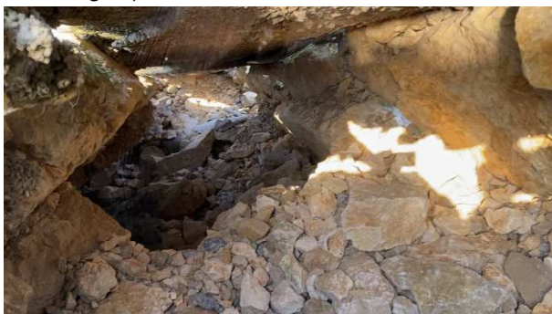
Cavité en direction du débarcadère
