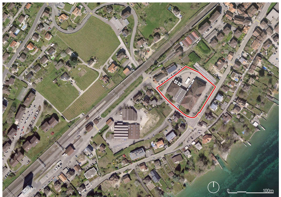
Fig. 13 : Localisation du site de l'ancienne vinaigrerie (bf 4962) – (source fond : ©SITN)
