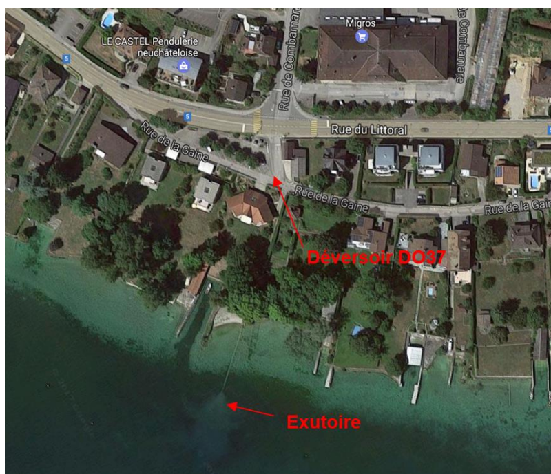
Vue aérienne du DO37 et de l'exutoire au lac
