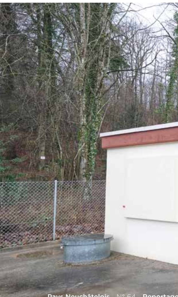
L'accès au puits artésien et le local de distribution. Un lieu sensible, stratégique même dans l'approvisionnement de la Commune en eau potable.
